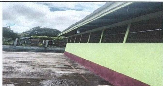
Foto 4: Sustitución de balcones de madera por metal
