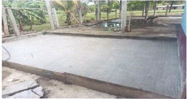
Foto 2: Piso de torta de concreto
