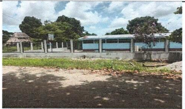
Foto 6: Repello de muro perimetral
