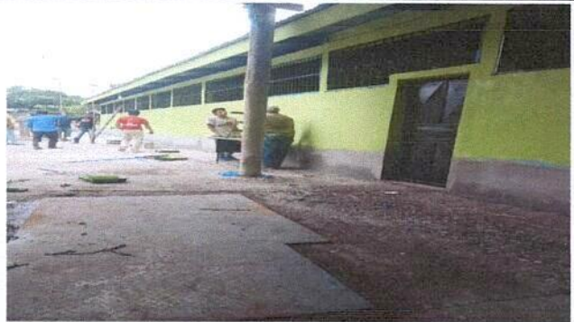
Foto 4: Sustitución de balcones de madera por metal
