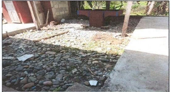
Foto 2: Piso de torta de concreto
