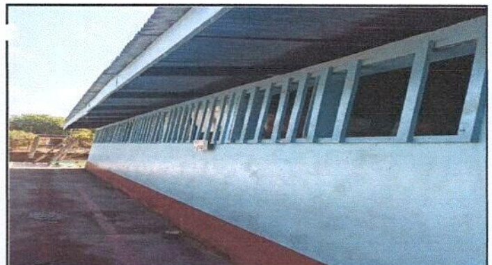
Foto 4: Sustitución de balcones de madera por metal
