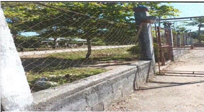
Foto 3: Reparación de muro perimetral del centro educativo público
