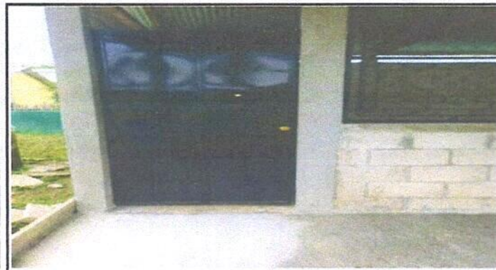
Foto 3: SUSTITUCION DE PUERTA DE COCINA
