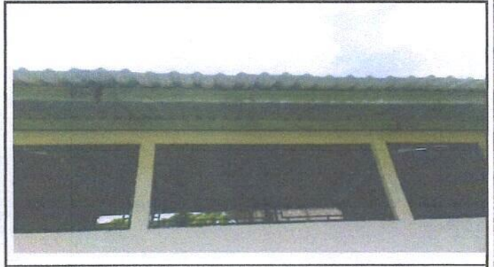
Foto 2: SUSTITUCION DE ESTRUCTURA DE TECHO EN COCINA.
