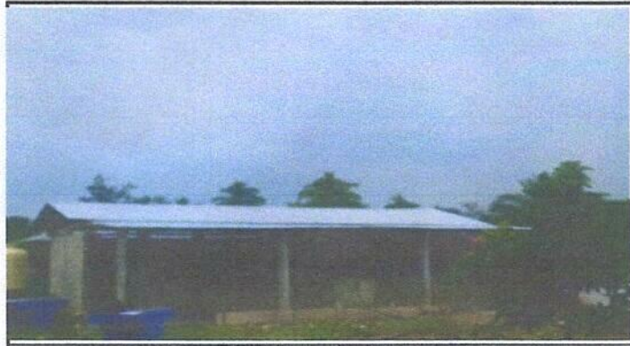
Foto 1: SUSTITUCION DE CUBIERTA DE LAMINA EN COCINA
