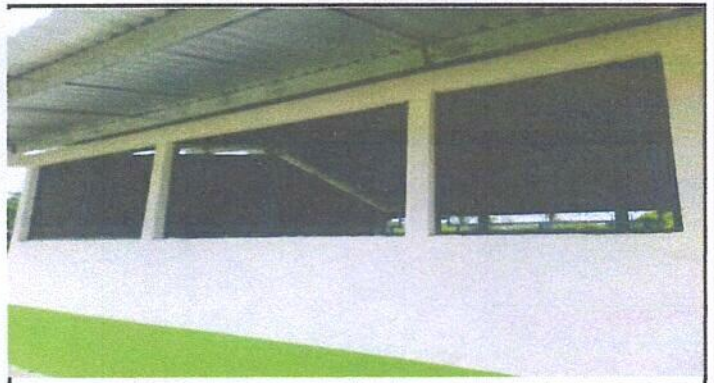
Foto 4: SUSTITUCION DE VENTANA DE AULA
