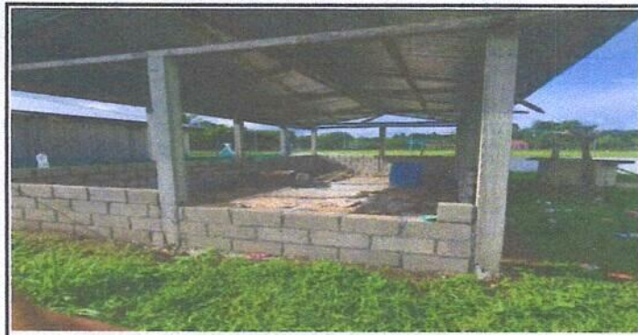
Foto 5: COLOCACION DE PISO EN COCINA
