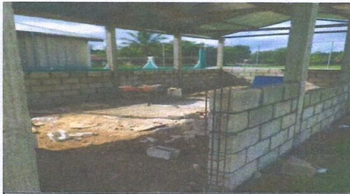
Foto 3: SUSTITUCION DE PUERTA DE COCINA
