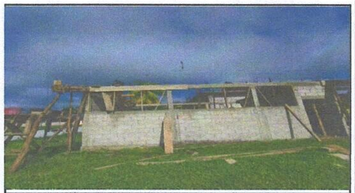
Foto 4: SUSTITUCION DE VENTANA DE AULA
