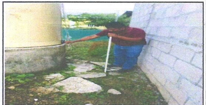
Foto 6: REPARACION DE RED DE AGUA POTABLE
