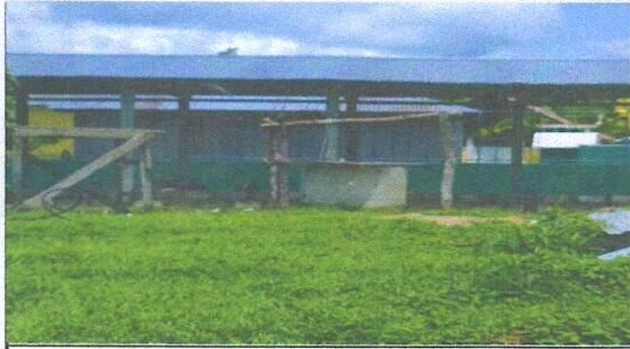
Foto 1: SUSTITUCION DE CUBIERTA DE LAMINA EN COCINA
