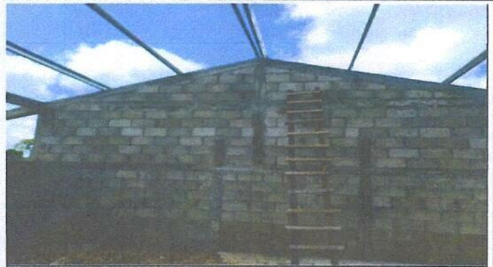
Foto 2: SUSTITUCION DE ESTRUCTURA DE TECHO EN COCINA.
