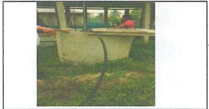
Foto 6: REPARACION DE RED DE AGUA POTABLE
