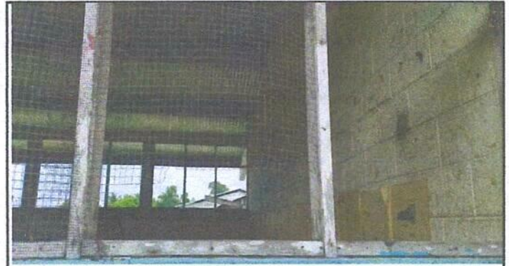
Foto 4: SUSTITUCION DE VENTANA DE AULA
