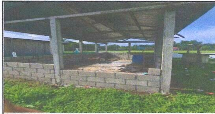
Foto 5: COLOCACION DE PISO EN COCINA
