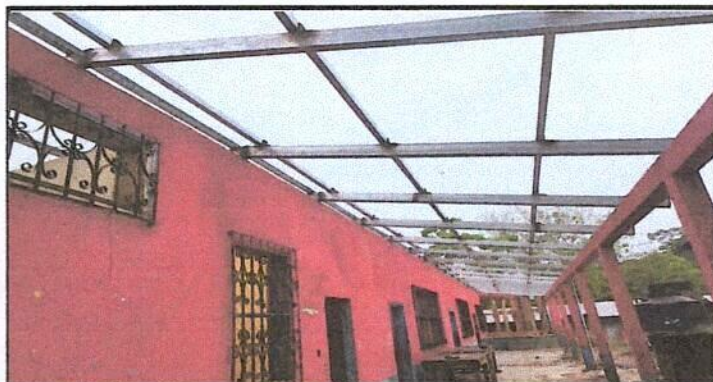
Foto 2: Instalación de estructura metálica.
