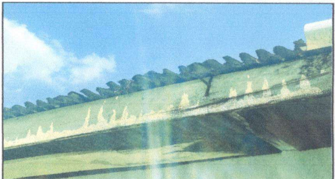
Foto 2: Sustitución de estructura de madera por metal del centro educativo público
