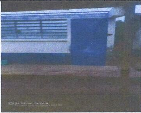
Foto 3: Aula del modulo 2 la puerta instalada
