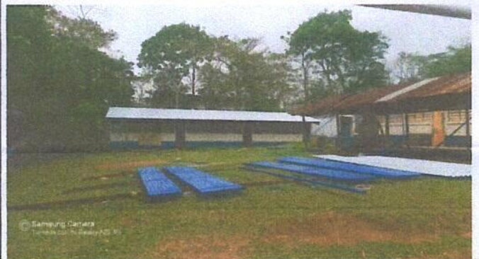
Inicio del montaje de lamina del modulo 2
