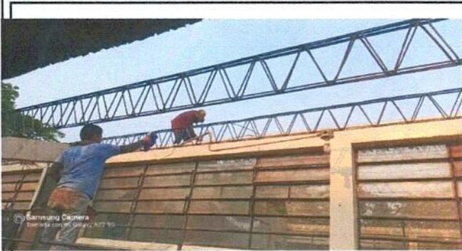
Foto 3: evidencia de la escuela modulo 2 en proceso de instalacion de estructura de metal.
