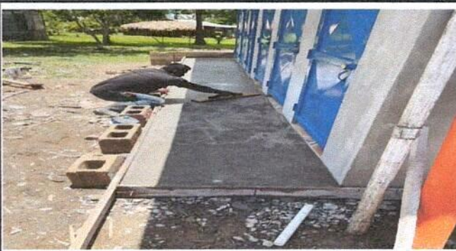
Foto 3: COLOCACION DE BANQUETAS
