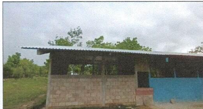
Foto 6: FIN DE TECHADO
