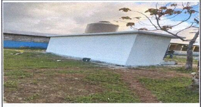
Foto 2: PINTURA DE CONSTRUCCION PARTE DE ATRÁS
