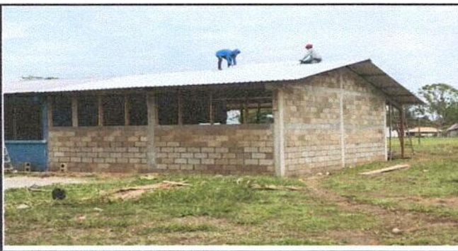
Foto 5: TERMINACION DE TECHADO
