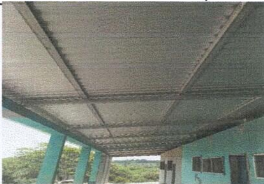
foto 5: sustitucion de estructura de madera a metal
