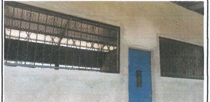
Foto 4: Colocacion 20 metros de balcones.
