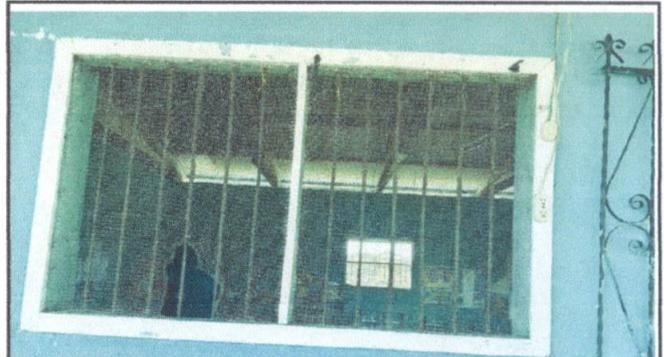
Foto 4: sustitucion de ventanas de madera por balcones de metal
