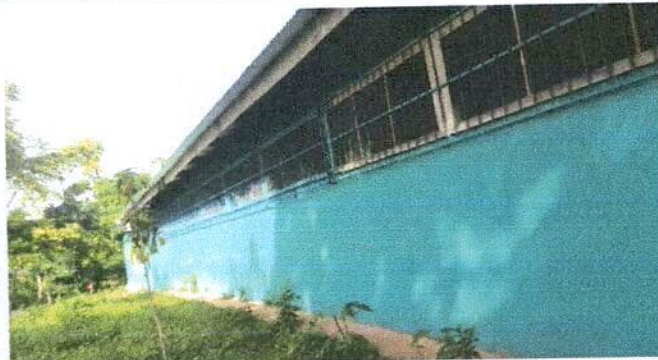
Foto 2: Balcones en la parte de atrás de la escuela, instalados. Trabajo terminado
