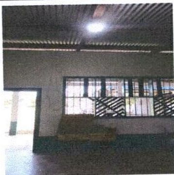
Foto 3: Instalación de sistema electrico. Trabajo finalizado
