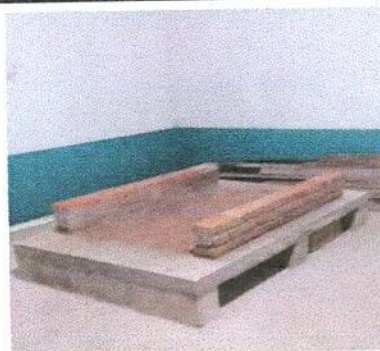
Foto 6: Plancha de concreto y ladrillo terminada
