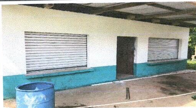
Foto 4: Persianas de aluminio de la cocina colocadas.
