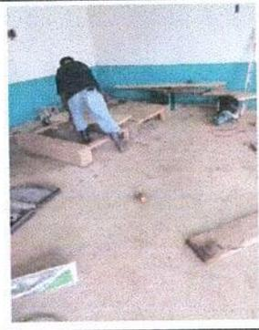
Foto 6: cambio de polleton por plancha de concreto y ladrillo
