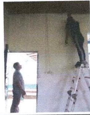
Foto 3: Instalación de nueva línea de cableado de energía electrica, bombillas, plafoneras, apagadores y tomacorrientes.
