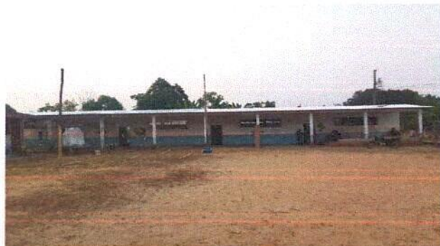
Foto 2: vista de la escuela con techo nuevo
