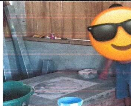
Foto 6: colocacion de la plancha de cocina de 2 hornillas
