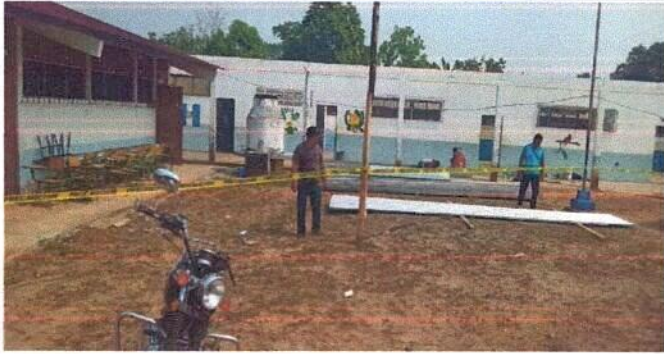
Foto1: Preparando el lugar por seguridad de los trabajadores
