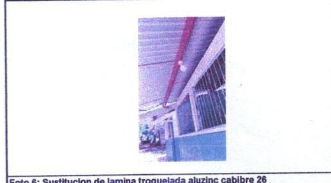
Foto 6: Sustitucion de lamina troquelada aluzinc cabibre 26
