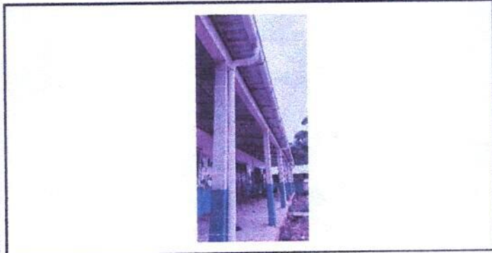
Foto 3: Sustitucion de lamina aluzinc calibre 26
