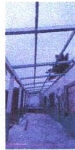
Foto 4: Sustrucion de estructura
