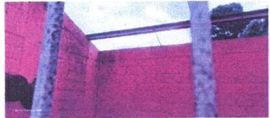
Foto 6: Sustrucion de lamina troquelada aluzinc cabibre 26
