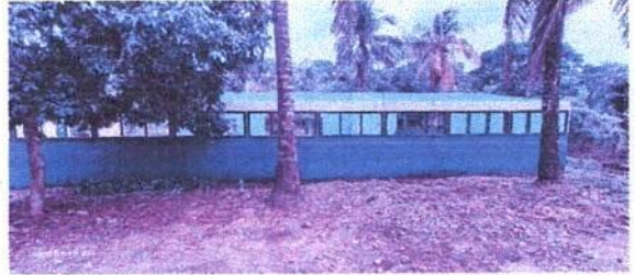
Foto 2: sustitucion de capote de lamina troquelada
