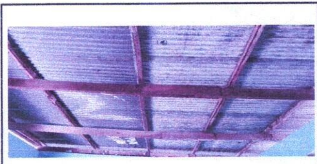
Foto 4: Sustitucion de estructura
