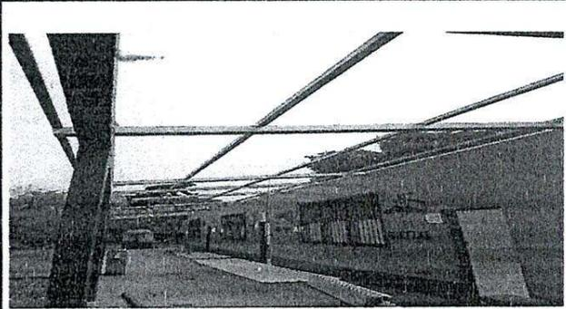
Foto 2: Haciendo la colocación de la estructura del techado.
