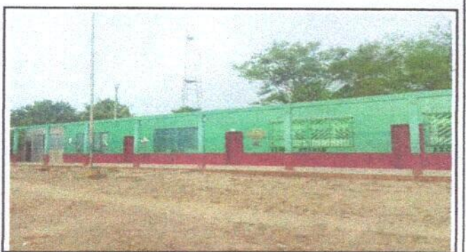
Foto 6: quitada de techo y lamina
