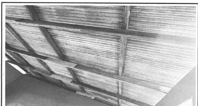
Foto 4: Sustrucion de estructura
