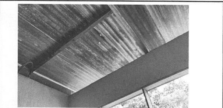
Foto 5: Sustrucion de estructura de soporte de mandera por metal
