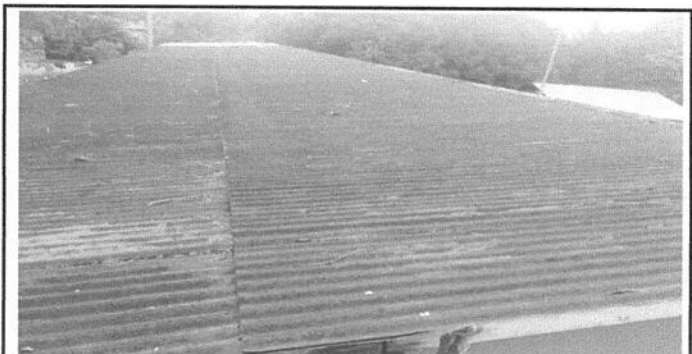
Foto 6: Sustrucion de lamina troquelada aluzinc calibre 26
