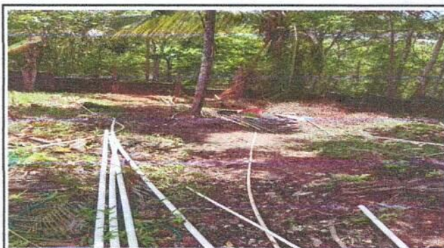
Foto 4: reinstalacion de tuberia de pozo.
