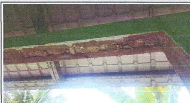
Foto 2: desinstalacion de ventanales de aula No. 1
