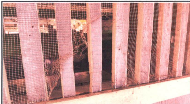
Foto 3: vista general de las ventanas de enfrente
