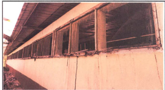
Foto 4: vista general de las ventanas de la parte trasera del establecimiento.
