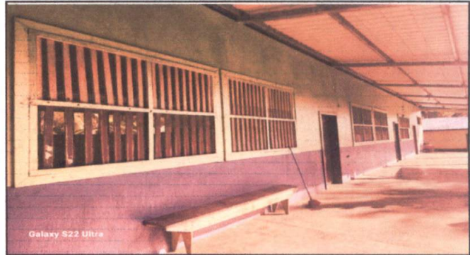
Foto 2: vista general de las aulas
