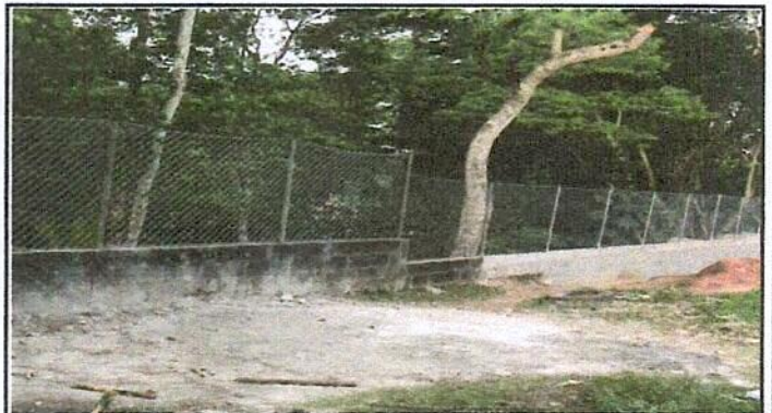
FOTO 2: Levantando el Muro
