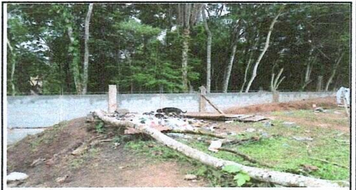
FOTO 4: Mallas y muro
