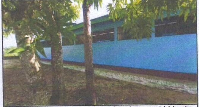
Foto 2: Módulo 2 Sustitucion de balcones de madera por metal del centro educativo publico
