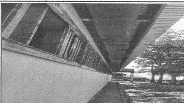
FOTO 2: Sustitución de balcones de madera por metal del centro educativo público
