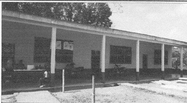
FOTO 1: Sustitución de puertas de madera por metal del centro educativo público
