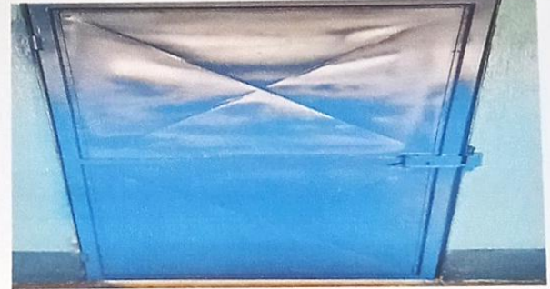
Foto 4: Puertas de metal
