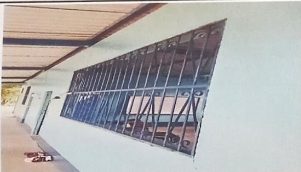
Foto 5: Ventana de balcones
