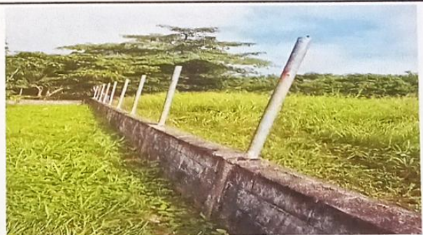
Foto 6: Reparacion de muro perimetral
