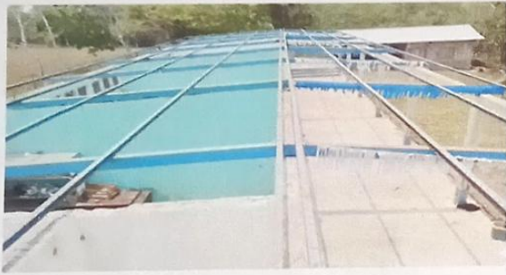
Foto 3: Reparacion de laminas
