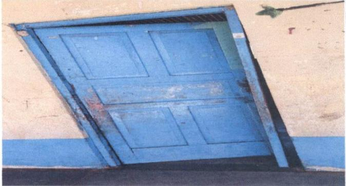
Foto 4: Puertas totalmente deterioradas
