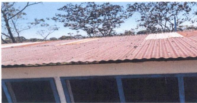
Foto 3: Lamina en muy mal estado
