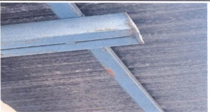
Foto 6: Estructura de metal con oxido
