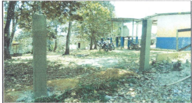
Foto 2: Instalacion de porton de metal para el Edificio Escolar
