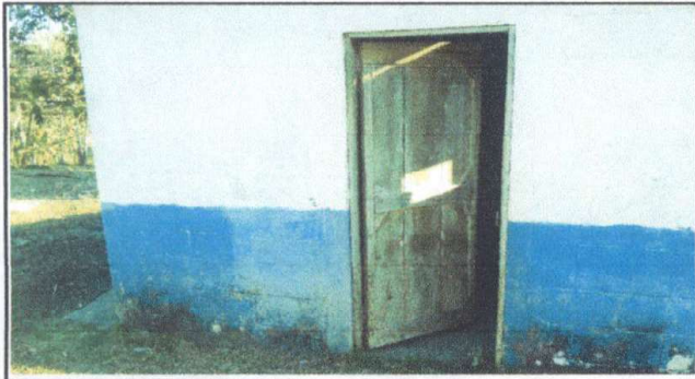
Foto 1: Instalacion de puerta de metal de la cocina
