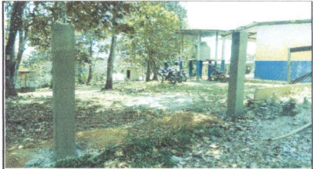
Foto 2: Instalacion de porton de metal para el Edificio Escolar
