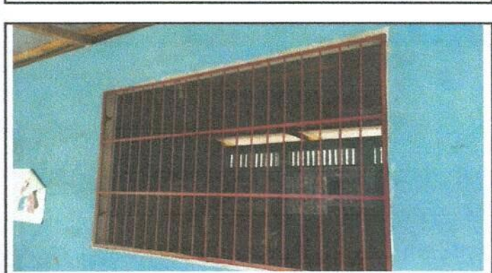
Sustitución de balcones de madera, por metal
