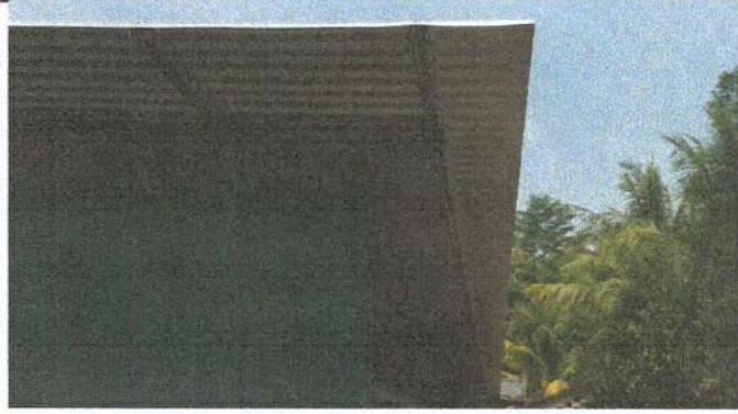
Sustitución de lámina, por lámina troquelada del edificio escolar
