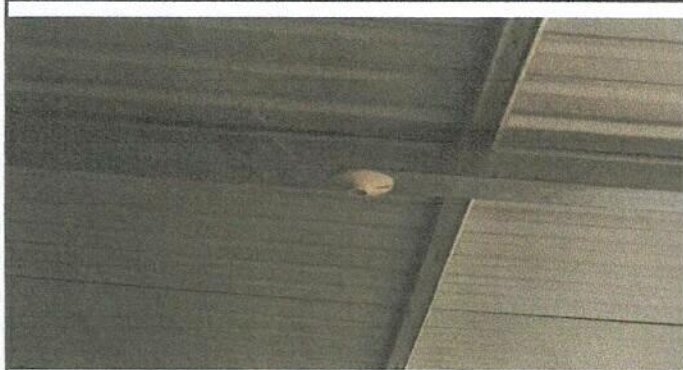
Sustitución de elementos de fijación
