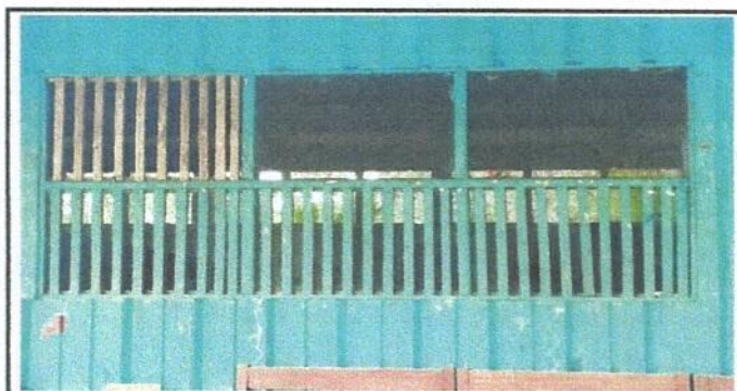
Sustitución de balcones de madera, por metal
