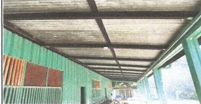
Sustitución de estructura de madera, por metal
