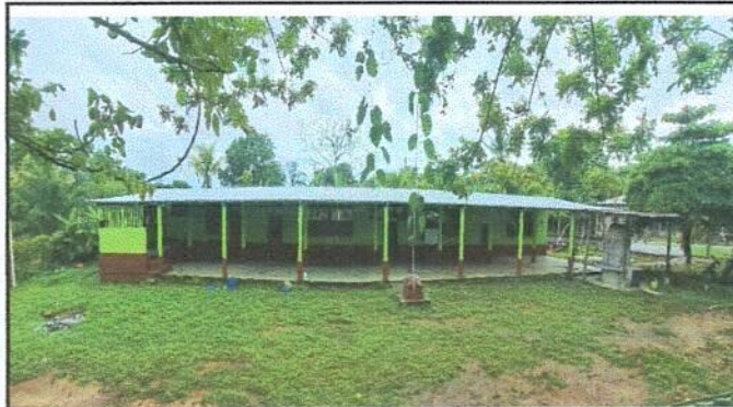
Foto 2: sustitucion de lamina, por lamina troquelada aluzinc calibre 26
