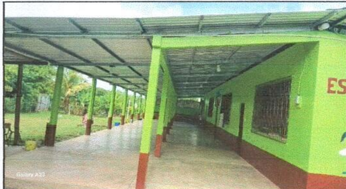
Foto1: Sustitucion de estructura de soporte de madera por metal
