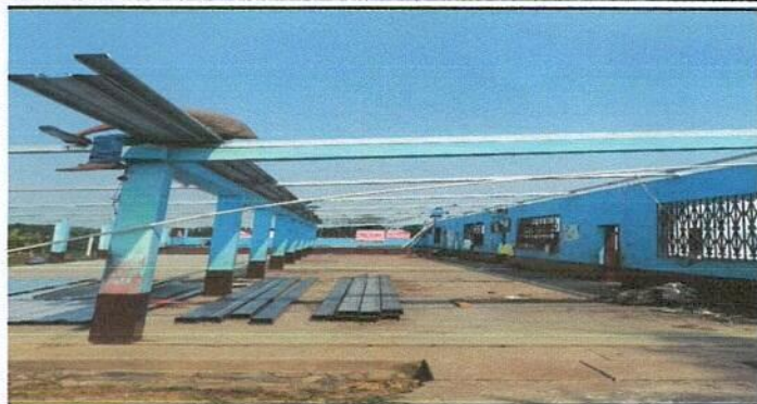
Foto1: Sustitucion de estructura de soporte de madera por metal
