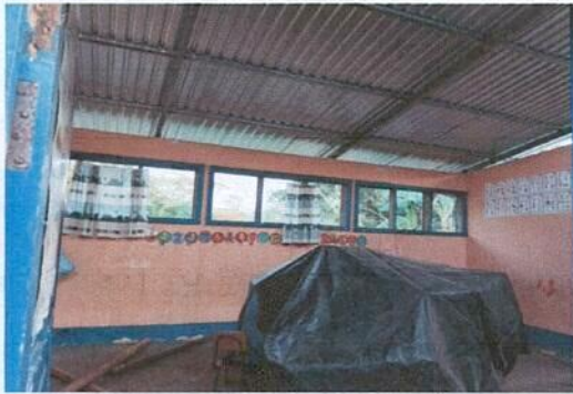
Foto 3: Modulo 2 Sustitución de estructura de soporte de madera, por metal
