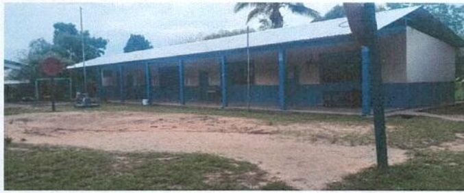
Foto 1: Modulo 1 Sustitución de lámina, por lámina troquelada
