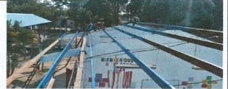
Foto 2: Modulo 2 Sustitución de lámina, por lámina troquelada
