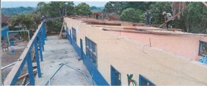
Foto 3: Modulo 2 Sustitución de estructura de soporte de madera, por metal
