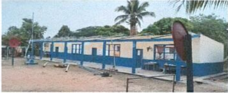
Foto 1: Modulo 1 Sustitución de lámina, por lámina troquelada
