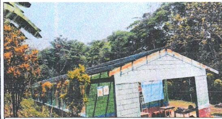
Retiro total de láminas, el inicio de la lijada de costaneras.
