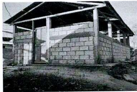
Foto 4: AULA DE PRE PRIMARIA SIN BALCONES.
