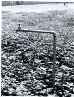
Foto 2. POZO. Instalación de suministros.
