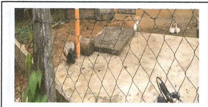
Foto 5: Fosa séptica terminada
