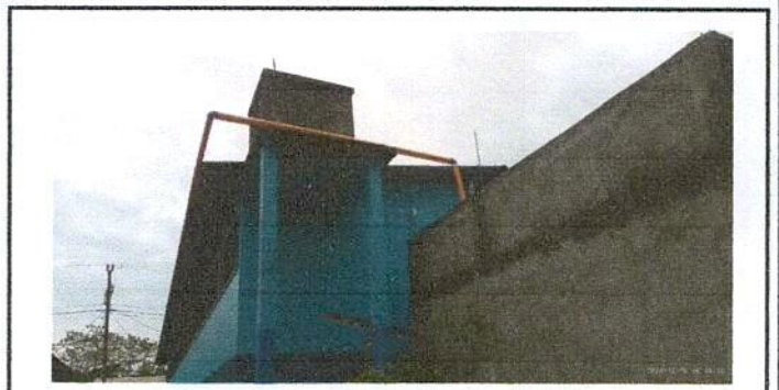
Foto 4: Colocacion de canaletas para captacion de agua terminada
