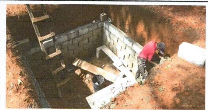
Foto 5: Reparacion de fosa séptica
