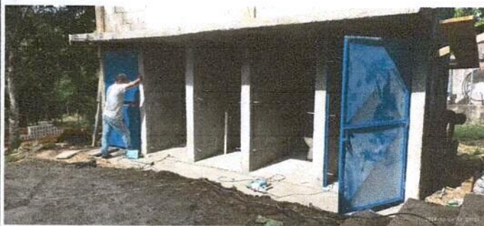
Foto 5: Instalación de puertas para baños
