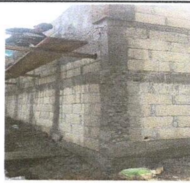
Foto 2: Aplicando repello en la pared
