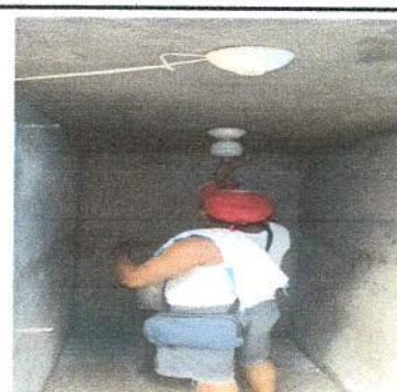
Foto 6: Instalacion de sistema electrica en los baños
