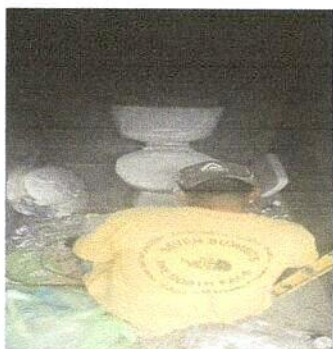
Foto 3: Instalación de inodoro
