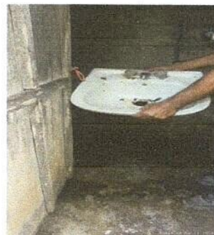
Foto 4: Sustitucion de lavamanos
