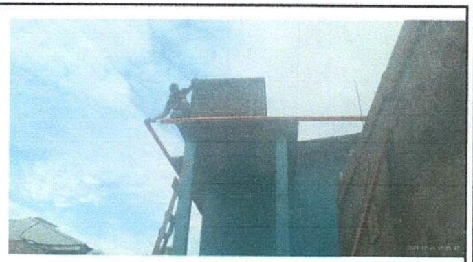
Foto 4: Colocacion de canaletas para captacion de agua
