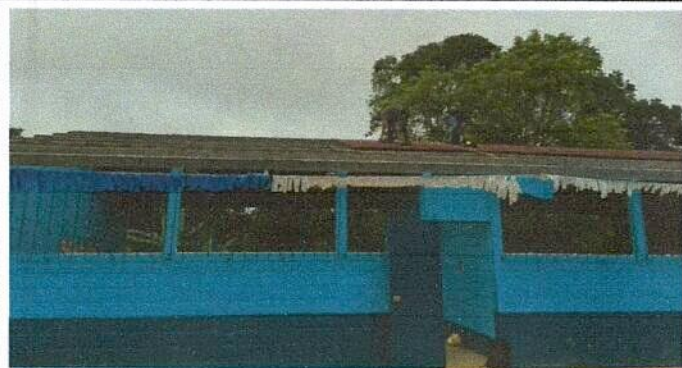
Foto 1: Desmontaje de cubierta de lamina existente
