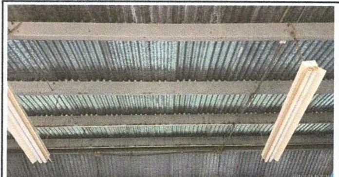
Foto 2: estructuras oxidadas
