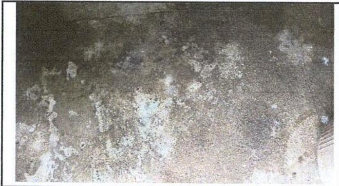
Foto 1: piso del baño rajada y picada
