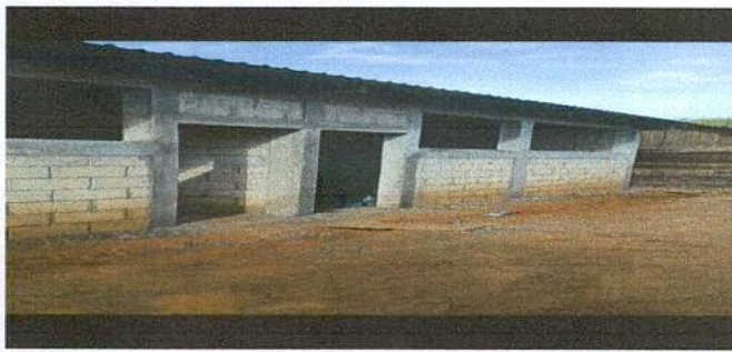
Foto 3: Instalación de puertas de metal del centro educativo
