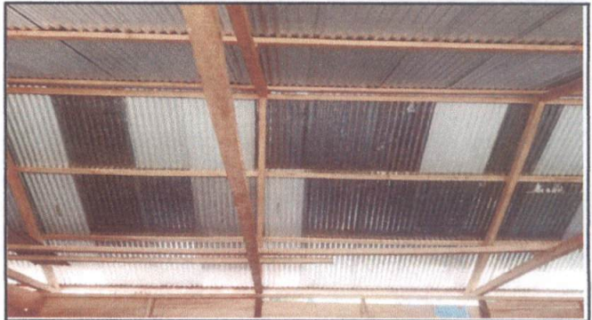
Foto 2: Sustitucion de estructura de madera por metal del centro educativo.
