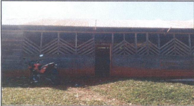
Foto1: Sustitucion de lámina, por lámina troquelada aluzinc calibre 26 del edificio escolar.
