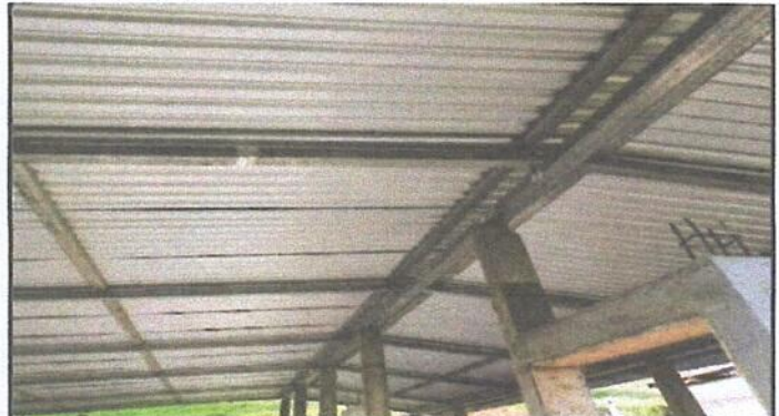
Foto 2: Sustrucción de estructura de soporte de madera, por metal del centro educativo
