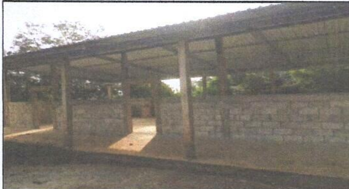
Foto 1: Sustrucción de lámina, por lámina troquelada aluzinc calibre 26 del centro educativo
