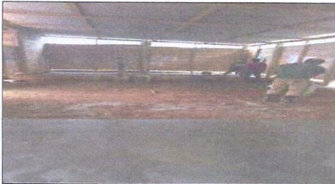
Foto 3: Piso de torta de concreto del centro educativo
