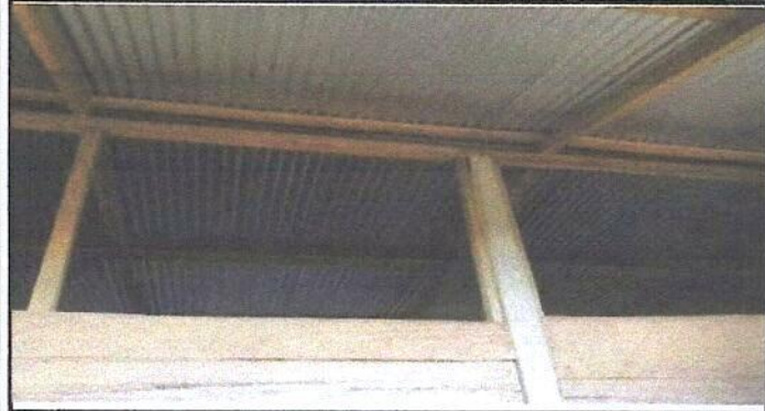
Foto 1: Sustitución de lámina, por lámina troquelada aluzinc calibre 26 del centro educativo
