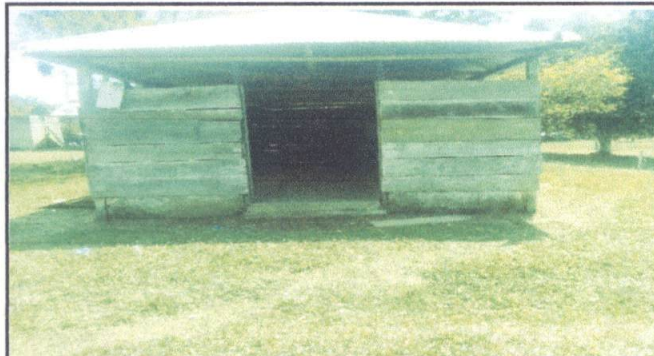
FOTO 3. Sustitucion de puerta de madera por metal del centro educativo.
