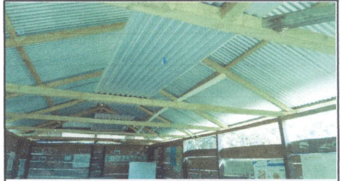
FOTO 2. Sustitucion de estructuras de madera por metal del centro educativo.
